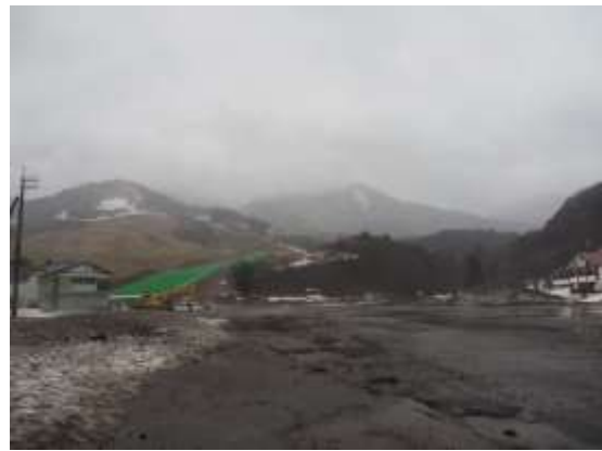
<前面のアスファルト舗装>
