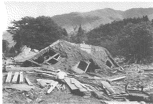
北美濃地震の被害（上打波）
