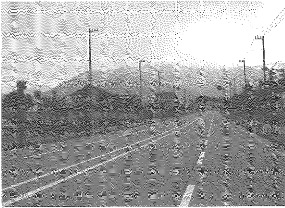
国道158号（右近次郎付近）
