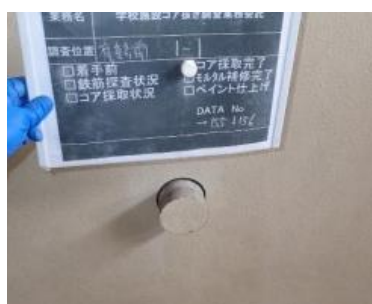
【コアの抜き取り状況】
