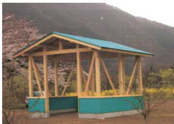
【花桃園地整備 (H27)】 休憩施設 (東屋) 完成
