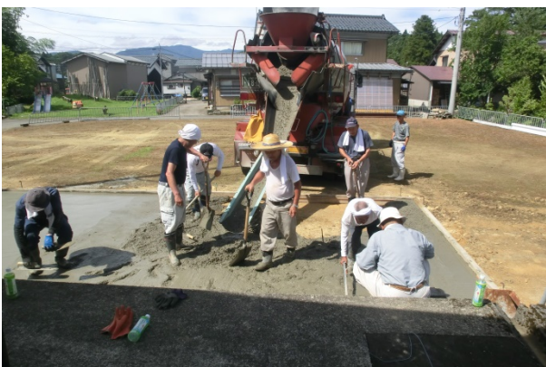
コンクリート打設作業
