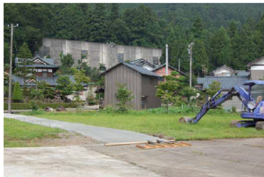
下黒谷地区の集落センター進入路の整備
