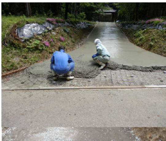
阿難祖領家地区の道路舗装
