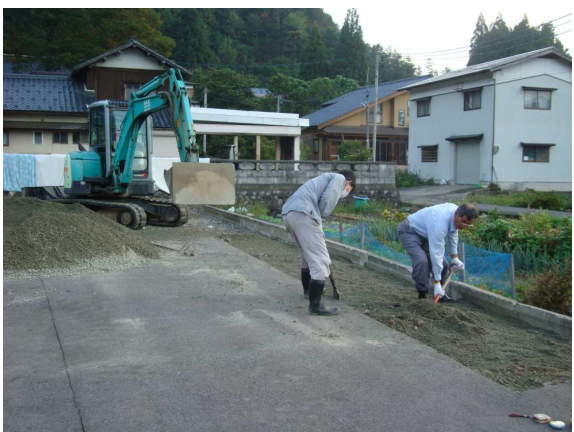
鉦掛地区のコンクリート舗装
