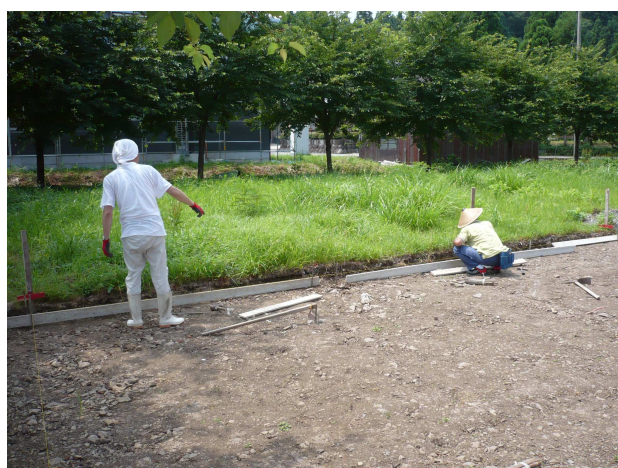
下黒谷地区の赤土による基礎整備
