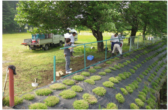
塚原区安全柵修繕（H23）
