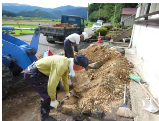
上荒井地区の集落センター外部コンクリート舗装
