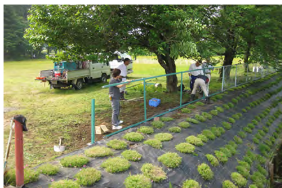
塚原区安全柵修繕 (H23)
