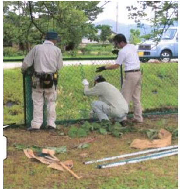
区民によるフェンス張り替え作業
