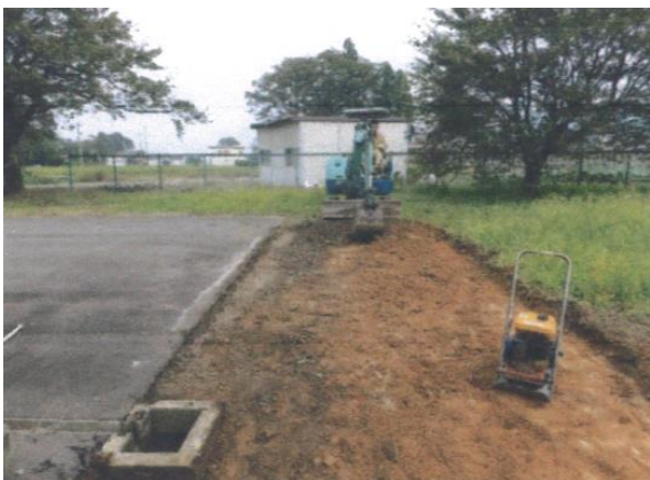
重機を借り上げての整地作業
