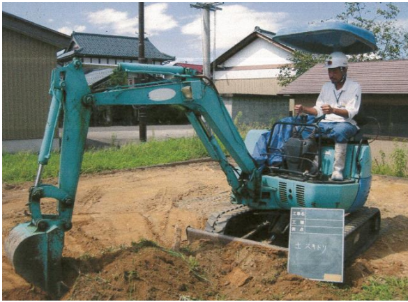
重機を借り上げての整地作業
