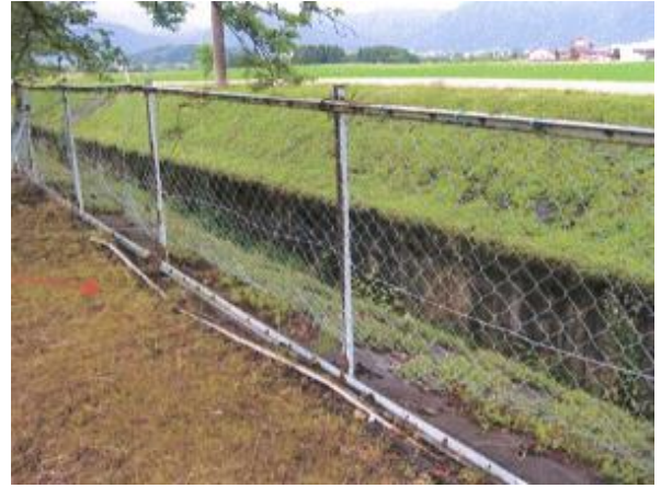
フェンス破損状況
