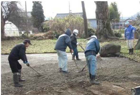
区民による整地作業
