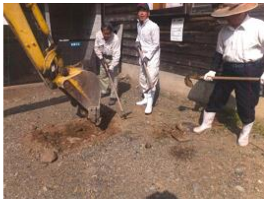
区民による整地作業
