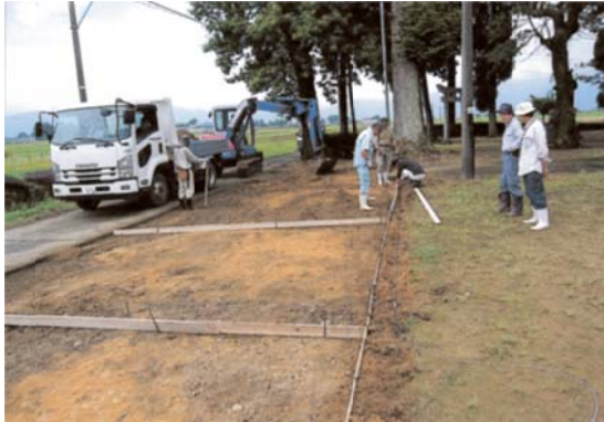
重機を借り上げすき取り作業
