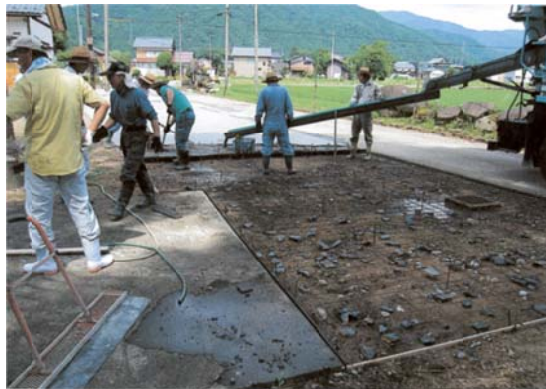
コンクリート打設作業
