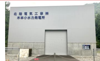
木本小水力発電所
