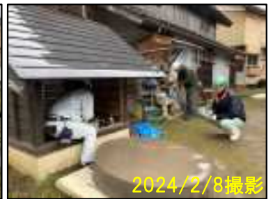
揚水試験実施状況
