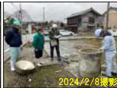
既設井戸現地調査状況
