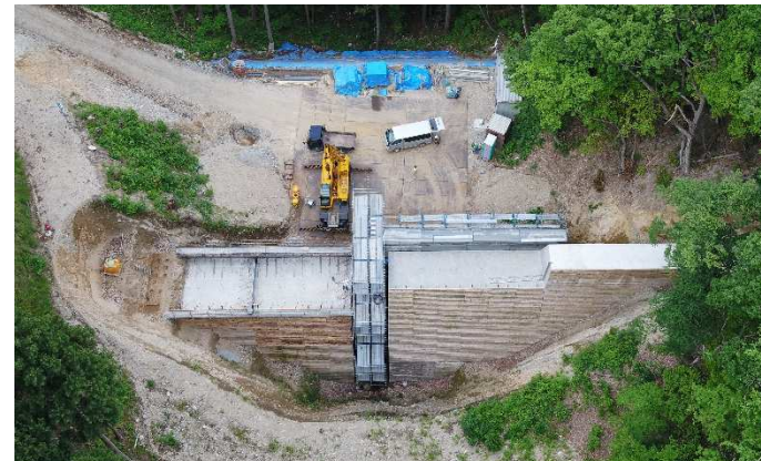
【砂防工事状況】
