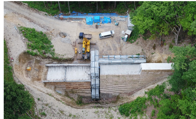
【砂防工事状況】
