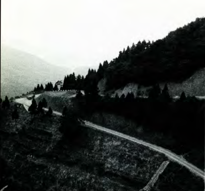
整備が進む林道（金山・桃木線）
