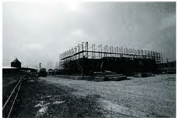
建設中の大野市下水処理センター
