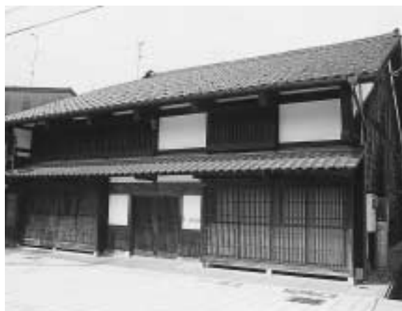
布川博雄氏宅(元町五 一二一) 七間通りに面し、一番通りから三番通りの間に位置しています。明治三十二年大火の後、建築され正面の木格子や広い間口、太い登梁やそで壁などが特徴的な建物です。
