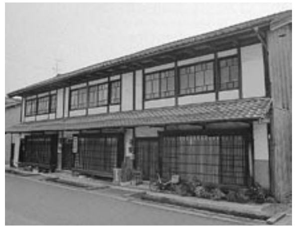
松山稲穂氏所有住宅(城町十一-二) 柳町通りに面し武家屋敷旧内山家から北二 件目に位置。昭和初期に建てられたとされ、 二階部分の白壁や美しく整った出格子が印象 的な長屋建てです。
