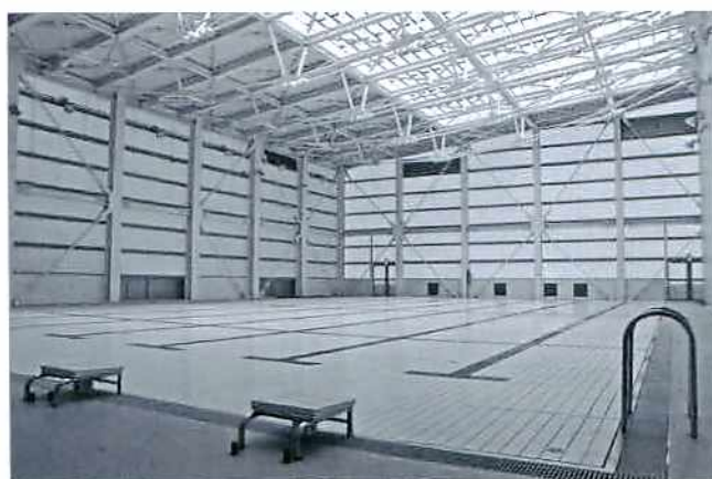
床が上がり、人工芝を敷くことで軽ス ポーツ室として利用できる屋内プール
