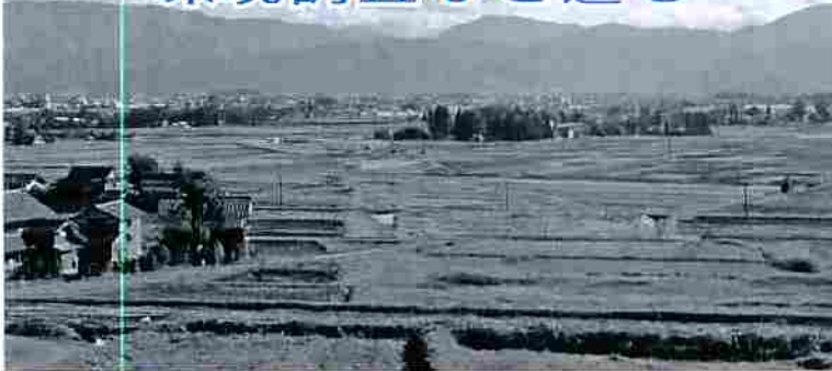
小矢戸地係から見た中部縦貫自動車道・永平寺大野道路の建設予定地。真正面に見えるのが太田区集落
