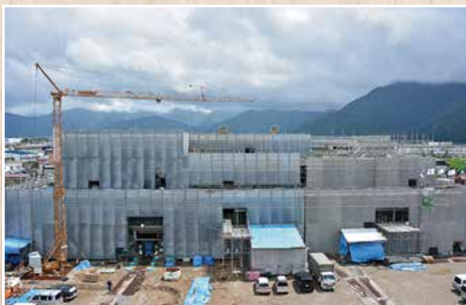
現庁舎横に整備中の市役所新庁舎
