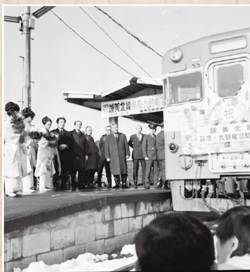
勝原―九頭竜湖駅間竣工開通式(昭和47年)
