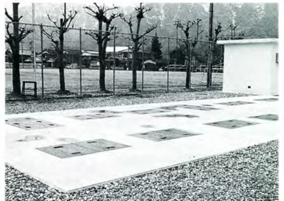
昨年、市役所に設置された合併処理浄化槽
