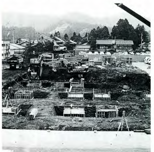
工事が進む庁舎裏
