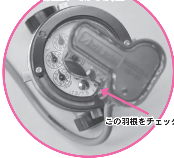
地中に設置してある水道メーター
