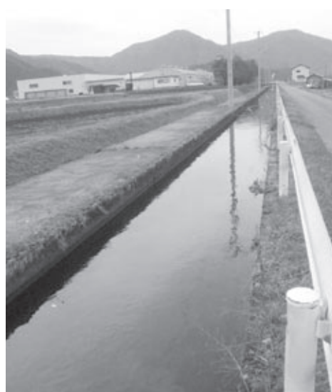
五条方地係の真名川用水頭首工から取水した水は、木の本原幹線水路と市所管の水路を経由して市街地に入ります。市街地の流雪溝用水や水路維持用水を流れて、赤根川に合流します。
