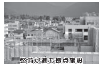
整備が進む拠点施設
