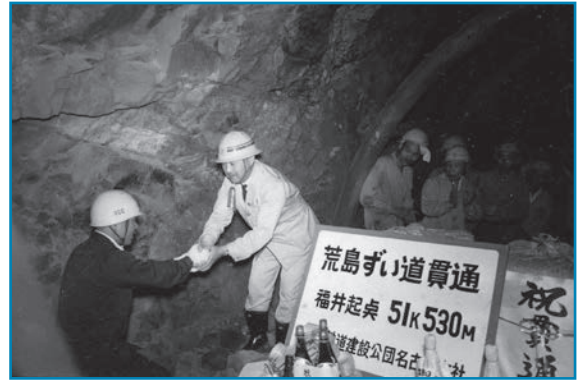
荒島トンネルの貫通：昭和45年7月撮影
