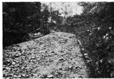
(写真は完成した林道)
