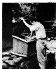
(ゴミ箱の取付け)
