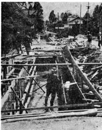
(写真は進む排水路工事)
