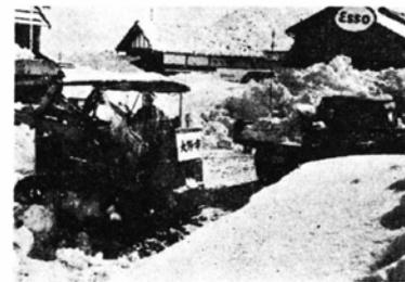
の除雪に全力を尽くしております。なお除雪によつて各河川につまつた雪は、各自で流していただき、浸水騒ぎが起らないよう十分ご注意ください。(▽真正はブルドーザーの除雪)
