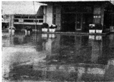
(融雪装置された庁舎前)
