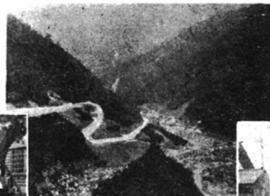
完成した市道仙翁谷線
