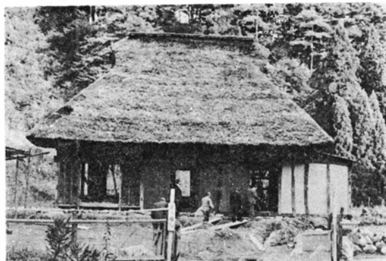
(完成が間近い橋本家)
