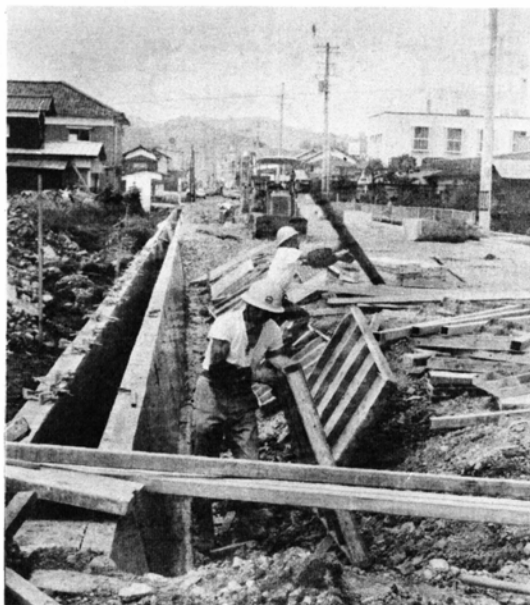
幹線道路七間線の舗装工事
