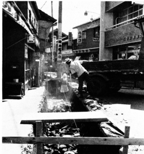
進む横町通りの流雪溝工事
