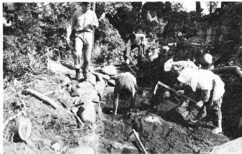
土塁の石垣を掘る作業員
