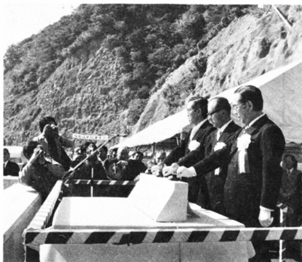
放水式で水門始動のボタンを押す 高橋建設事務次官ら
