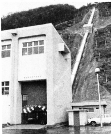
事業費約40億円をかけ完成した県営真名川発電所
