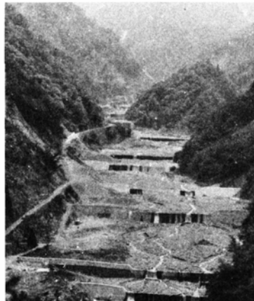
約100メートルごとに設けられた砂防えん堤
