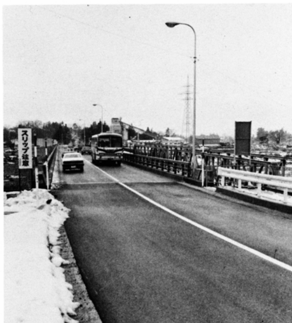
右岸（松丸寄り）から見た新阪谷橋
