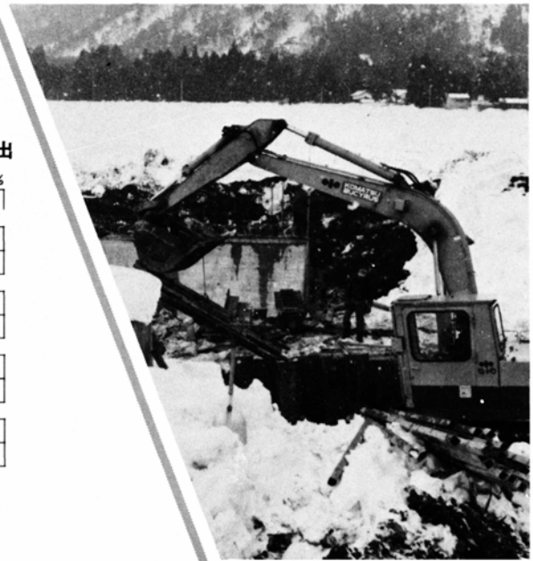
工事進む深井橋
