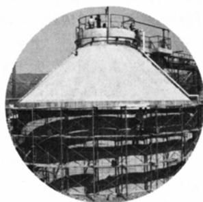
▲4月1日 老朽化した衛生処理場を改築。新しく加圧浮上槽を設置し、処理行程を増やしました。
