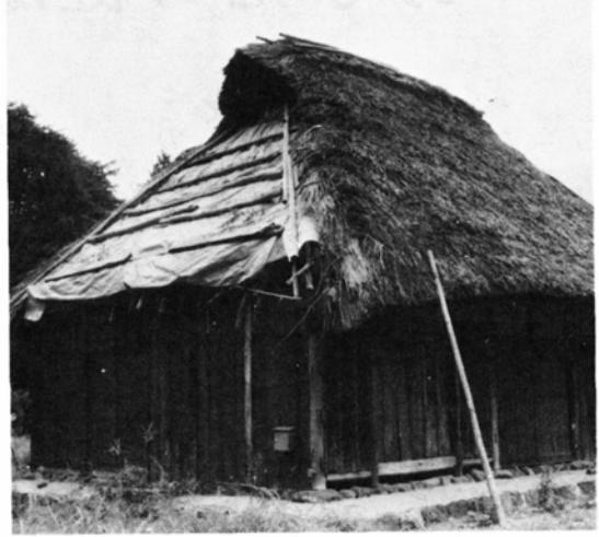
修復される橋本家の屋根
