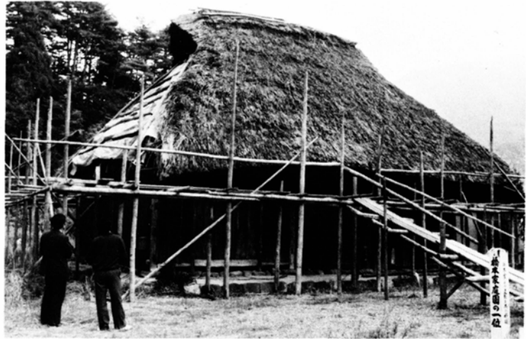
足場が組まれた橋本家
