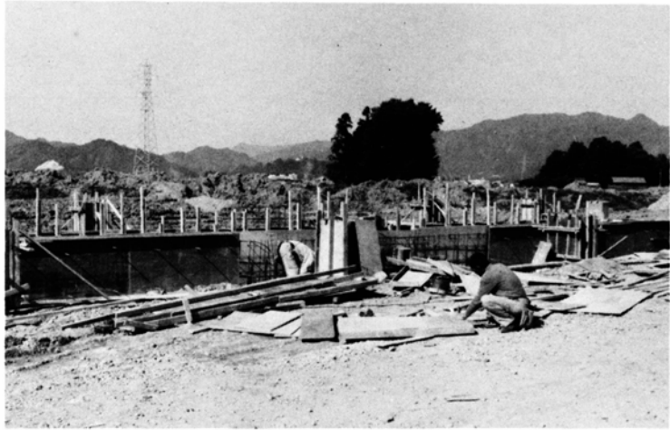
基礎工事が進む加工場
