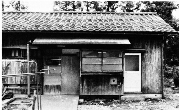
改良された市営住宅
