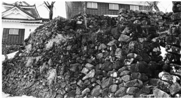
補修される大野城の野面積み石垣
