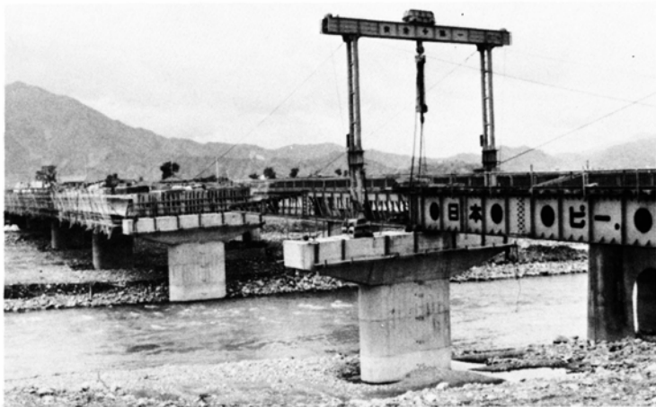
上部構造の工事が進む君が代橋
